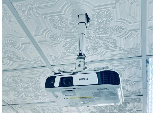
ลักษณะการติดตั้งพร้อมใช้งาน
