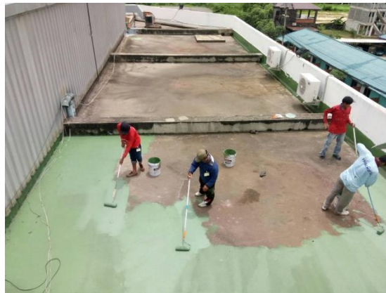
บริษัท เพิ่มเพียร คอนสตรัคชั่น แอนด์ เทรตติ้ง จำกัด ประกอบกิจการงานกันซึม
