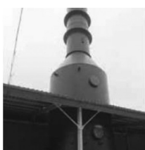
รูปที่ 13 เครื่องดักจับก๊าซพิษไซยาไนด์ 8 หรือ scrubber และกำจัดก๊าซพิษไซยาไนด์ด้วยสารเคมีโซเดียมไฮโปคลอไรด์ (NaClO) ภายใต้ระบบปิด ก่อนปล่อยสู่บรรยากาศ เหลือก๊าซพิษไซยาไนด์ 0.01 ppm
