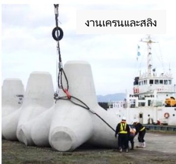
งานเครน (งานถมหินสำหรับถมไต้หน้า)
