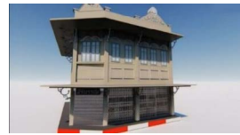
ภาพที่ 22 การออกแบบมีการประยุกต์ให้เข้ากับสภาพภูมิอากาศในเขตร้อนชื้นของภาคใต้ได้เป็นอย่างดี โดยการใช้หลังคาพื้นคอนกรีตบริเวณด้านหน้าอาคาร การออกแบบช่องลมและใช้หน้าต่างบานเกล็ดเพื่อให้อากาศถ่ายเทสะดวก
