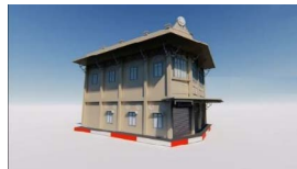
ภาพที่ 21 การเน้นหน้าบ้านและตกแต่งลวดลาย ปูนปั้นภายใน การก่อผนังล้อมขอบหลังคา การออกแบบลานอเนกประสงค์ที่มีบ่อน้ำซึ่งถือคติความเชื่อจากชาวจีน และการออกแบบหลังคาคอนกรีตแบน
