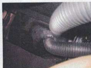
รูปการติดตั้งท่อระบายก๊าซ
